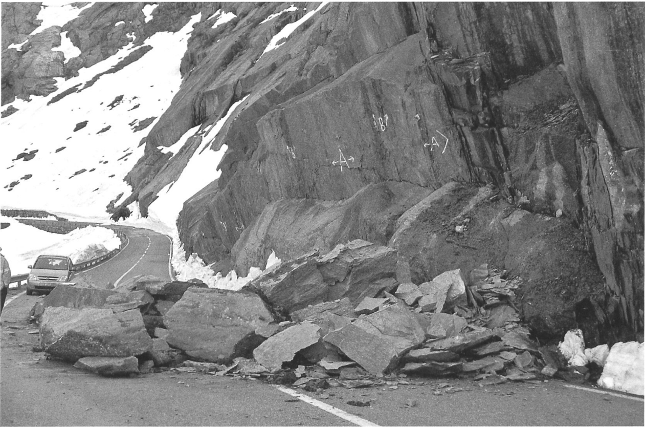
Fig. 2: Beispiel eines Sturzereignisses im Frühling mit einer grösseren Anzahl von kleinen Blöcken: An der Grimselpassstrasse (Kanton Bern) stürzten im Mai 2007 nach einem kalten Winter rund 30 \text{ m}^3 Fels auf die Strasse.
